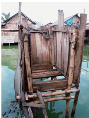
途上国で見られるトイレ：排泄物は直接川や湖沼へ垂れ流しとなります。
