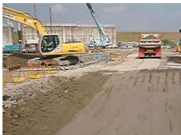
道路盛土工事
