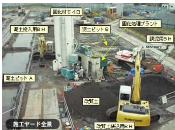
固化材処理施工ヤード全景
