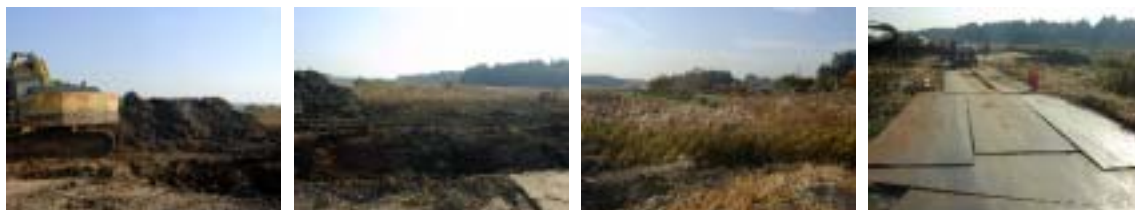
(c) 現場状況写真
