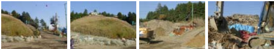
(c) 現場状況写真
